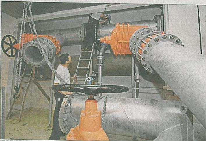
**VIBRATIONS** Des travaux ont été entrepris afin de réduire les vibrations du courant d'eau dans les conduites. La société Hydro-Concept attend désormais des manchettes antivibrations fabriquées sur mesure en Allemagne.
